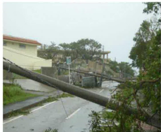
写真－1 台風による電柱倒壊状況
