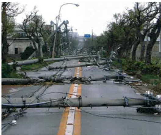
写真－1 台風による電柱倒壊状況
