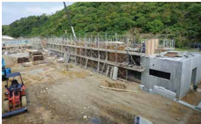
本部中学校仮設校舎建設工事 (渡久地)
