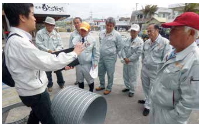
本部町公共下水道改築工事 (大浜)
