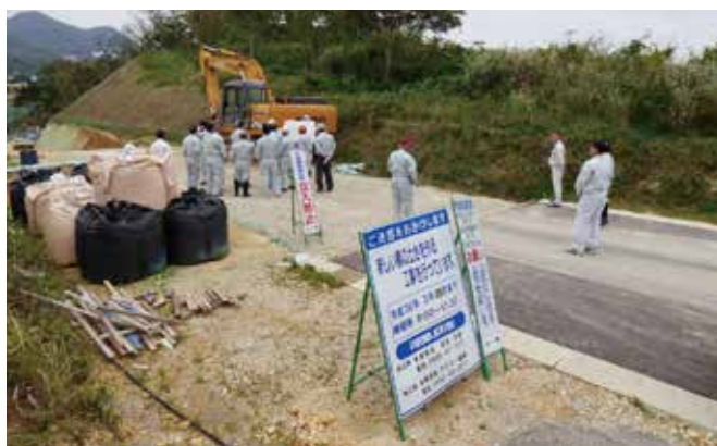
石川謝花線橋梁整備工事 (豊原)
