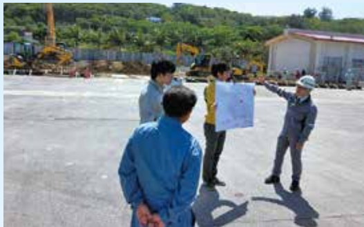
田空ハーソー公園屋根施設新築工事
