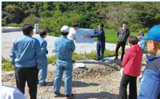
笹川新浄水場建設工事
