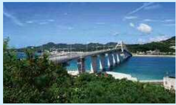
瀬底大橋：1985年(昭60)開通 橋長763m
