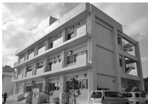
▲琉球大学熱帯生物圏研究センター瀬底研究施設入口近くに完成した新管理棟
