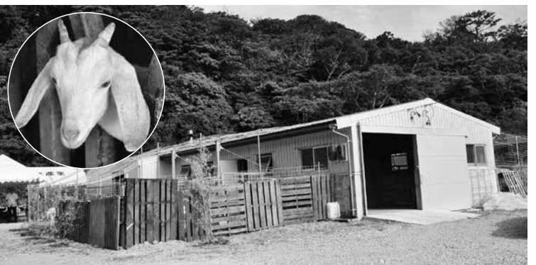
▶字辺名地に完成した山羊舎
