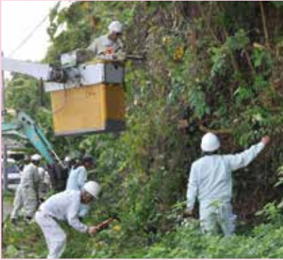
▲重機を駆使して手際よく伐採
