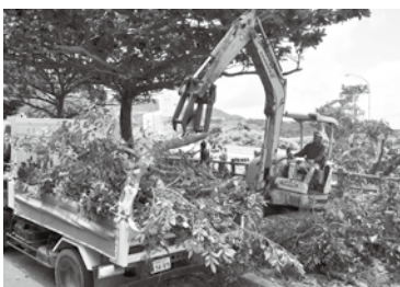
▲伐採作業をする建設業者会の皆さん
