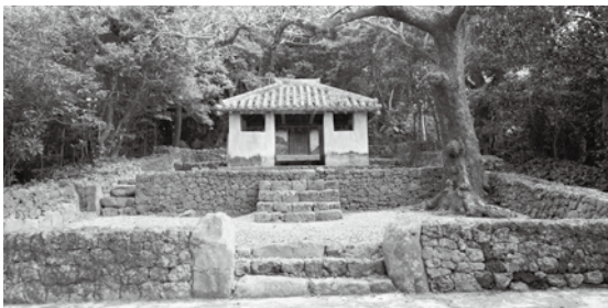
①「瀬底土帝君」農神土帝君を祭る礼拝施設で県内42か所のうち最も大きく昔の状態で保存されている（国指定重要文化財）
