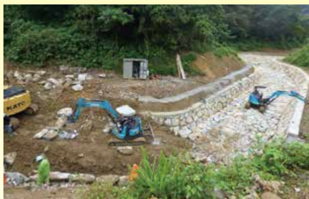
八重岳親水性護岸整備工事②
