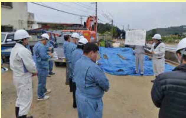
伊野波橋橋梁整備工事
