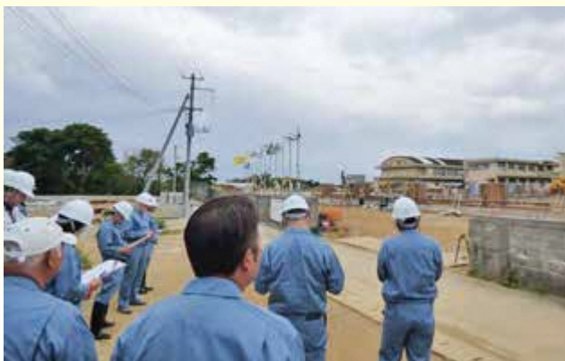
上本部小中一貫校校舎建設工事
