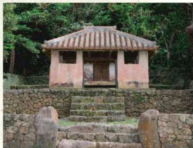
瀬底土帝君一郭 （国指定重要文化財／建造物）
